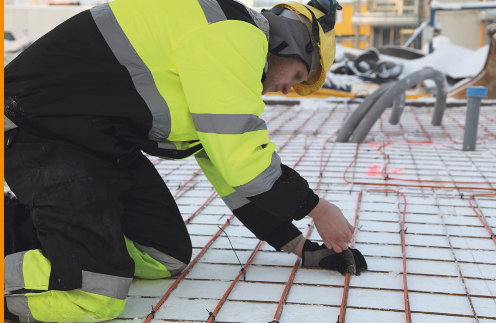
BET-lämmityskaapelin kiinnittäminen raudoitusverkkoon nippusiteillä
