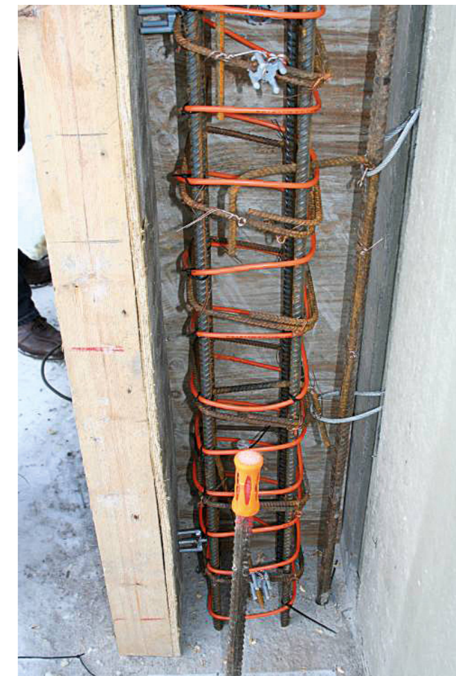
Lämmityskaapeloinnin asentaminen pilariin, vaihtoehtoisesti lämmityskaapelit voidaan sijoittaa pystyyn.
