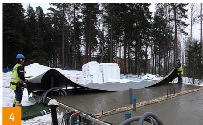
Talvibetonoinnin vaiheet BET-lämmityskaapeilla: 1. BET-lämmityskaapelin asennus 2. Jään ja lumen sulatus 3. Betonin valu, jonka jälkeen BET-lämmityskaapelit kytetään päälle 4. Valun suojaaminen.
