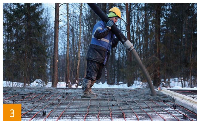
Talvibetonoinnin vaiheet BET-lämmityskaapeilla: 1. BET-lämmityskaapelin asennus 2. Jään ja lumen sulatus 3. Betonin valu, jonka jälkeen BET-lämmityskaapelit kytetään päälle 4. Valun suojaaminen.
