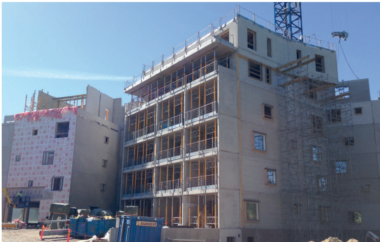
Kuva 8. Kuvassa näkyy runkovaiheessa oleva asuinkerrostalo, jossa testimittaukset tehtiin kesällä 2015.
